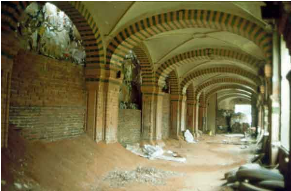
AK Bergbau: Heft 28, Abb. 24, (Ludwig Kraus, 1996) In den Seitenschiffen der Kaue sind die Kreuzgrad- Gewölbedecken und Arkadenbögen zum Teil noch erhalten
