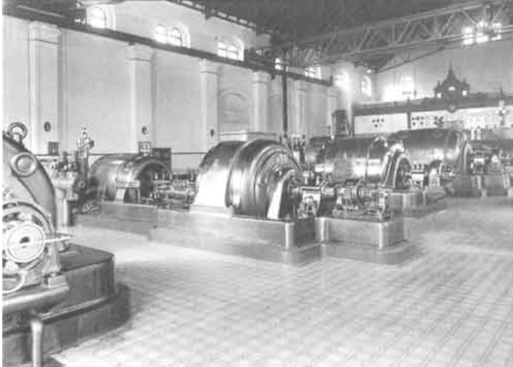
AK Bergbau: Heft 28, Abb. 7, ca. 1940 (Berg- und Stadtmuseum Obernkirchen) Vier Maschinensätze im Kraftwerk Georgschacht mit Turbogeneratoren
