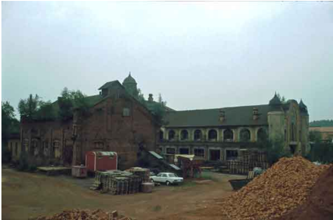
AK Bergbau: Heft 28, Abb. 23, (Ludwig Kraus, 1996) Fördermaschinenhaus Schacht 1 und Zechenhaus mit Verwaltung
